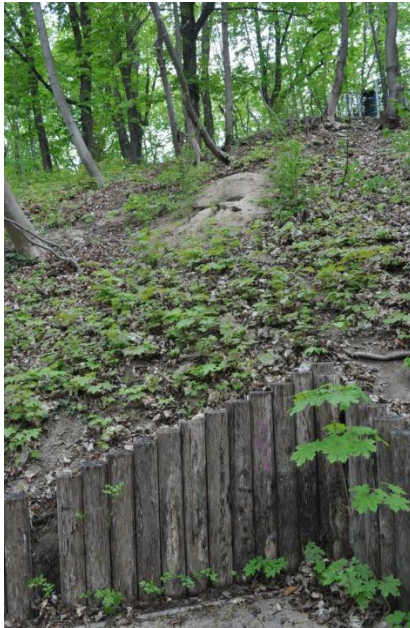
Abbildung 28: Stütz wand des
